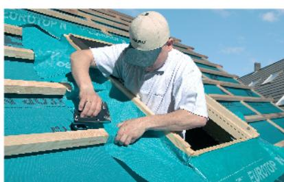
Аксессуары для монтажа обеспечивают правильное и надежное соединение окна с конструкцией кровли, отличную гидро-, паро- и теплоизоляцию в зоне окна для крыши и более длительный срок службы окна.
