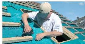
Универсальная система монтажа FAKRO: окна могут быть установлены как на стропилах, так и на обрешетке. Широкая региональная сеть техподдержки и сервис-центров позволяет проводить бесплатную сертификацию монтажных бригад, осуществлять выезд на объект и предоставлять бесплатные консультации.
